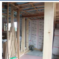
⑤天井：高性能GW 155ミリ 壁：高性能GW 105ミリ
