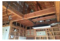
②骨組み状態まで解体してしまいます。
