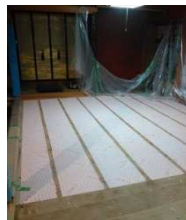
④床の断熱材施工
