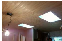
⑥造作工事
