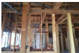
②解体工事
