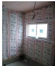
⑤壁・天井の断熱材施工
