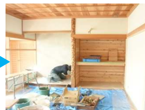
⑦内装工事
